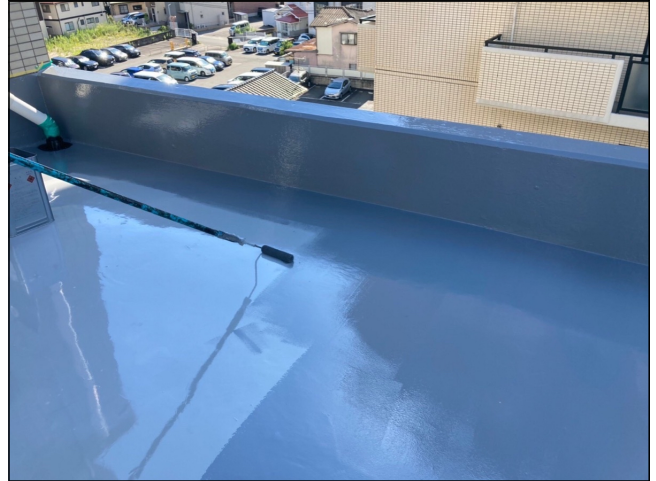
紫外線や雨風で塗膜の劣化を防止するための保護塗料を塗ります
